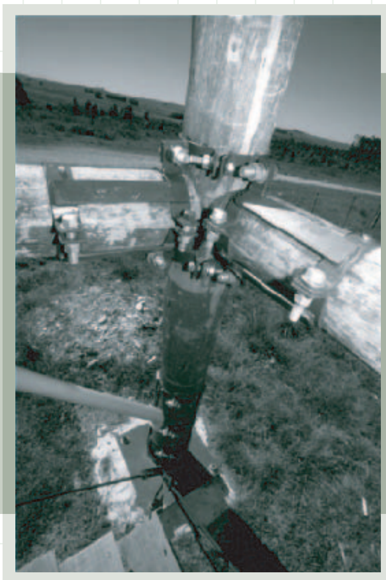
"Pieza metálica de unión para torre hecha en madera"
