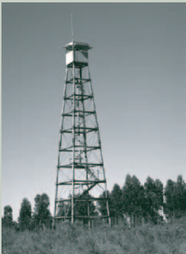
> Torre realizada sobre fundamentos de hormigón, con columnas de Eucalyptus Grandis tratados y unidos con sunchos de acero
